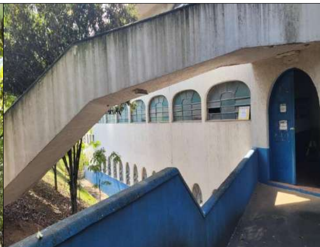
FOTO 90 – ÁREA EXTERNA VESTIÁRIOS
