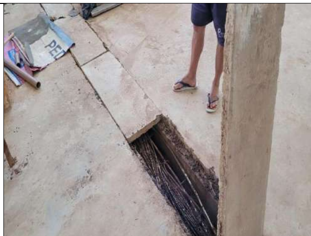
FOTO 70 – CASA DE MÁQUINAS PISCINA RECREATIVA
