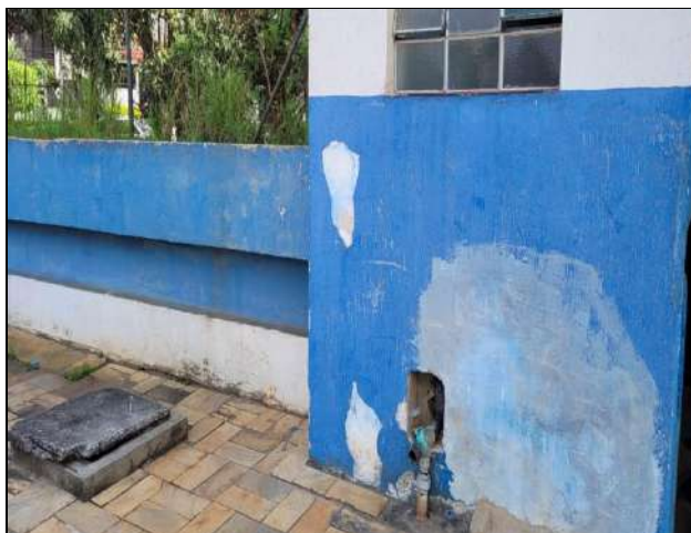
FOTO 63 – ÁREA EXTERNA VESTIÁRIO
