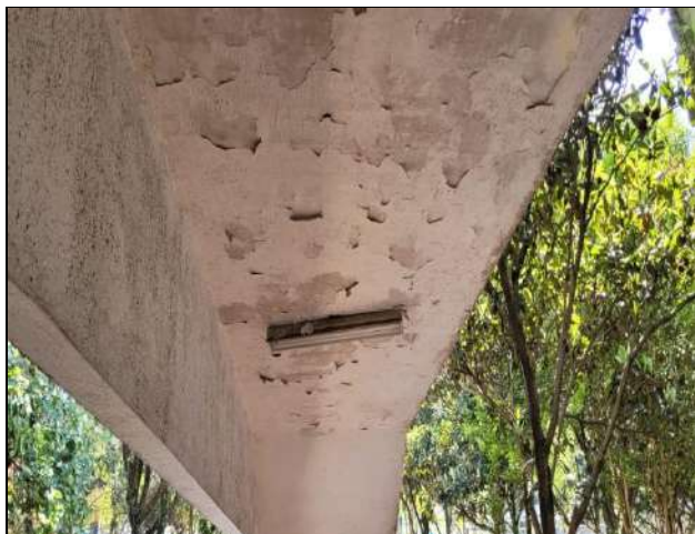
FOTO 89 – ÁREA EXTERNA VESTIÁRIOS
