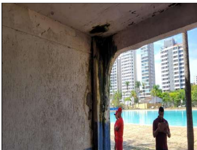
FOTO 59 – ÁREA EXTERNA VESTIÁRIOS
