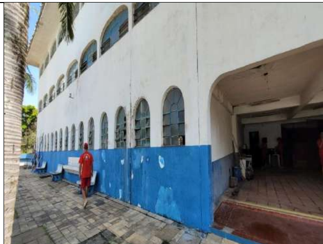
FOTO 62 – ÁREA EXTERNA VESTIÁRIOS
