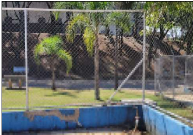
FOTO 21 – ALAMBRADO E MURETA PISCINA SEMIOLÍMPICA
