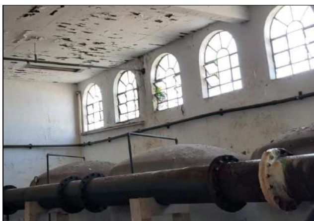
FOTO 39 – CASA DE MÁQUINAS DA PISCINA RECREATIVA
